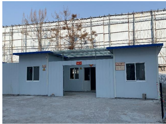
医疗废物暂存间
